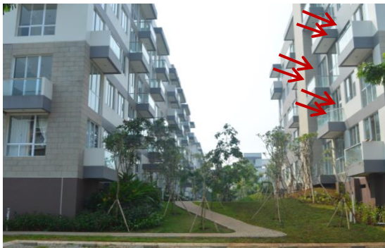
Gambar 1. Perbedaan letak balkon untuk memaksimalkan pencahayaan alami
